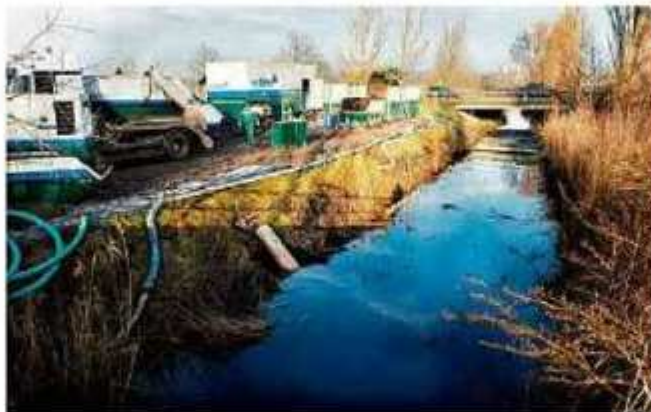
Durch Schläuche werden die Ablagerungen transportiert. FOTO: JÜRGEN LUKASCHKE
